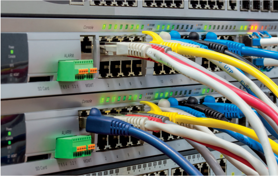
■ الشكل 1.10 يحتوي المحول على عدد من المنافذ للكابلات التي سيتم توصيل الكابلات بها.
